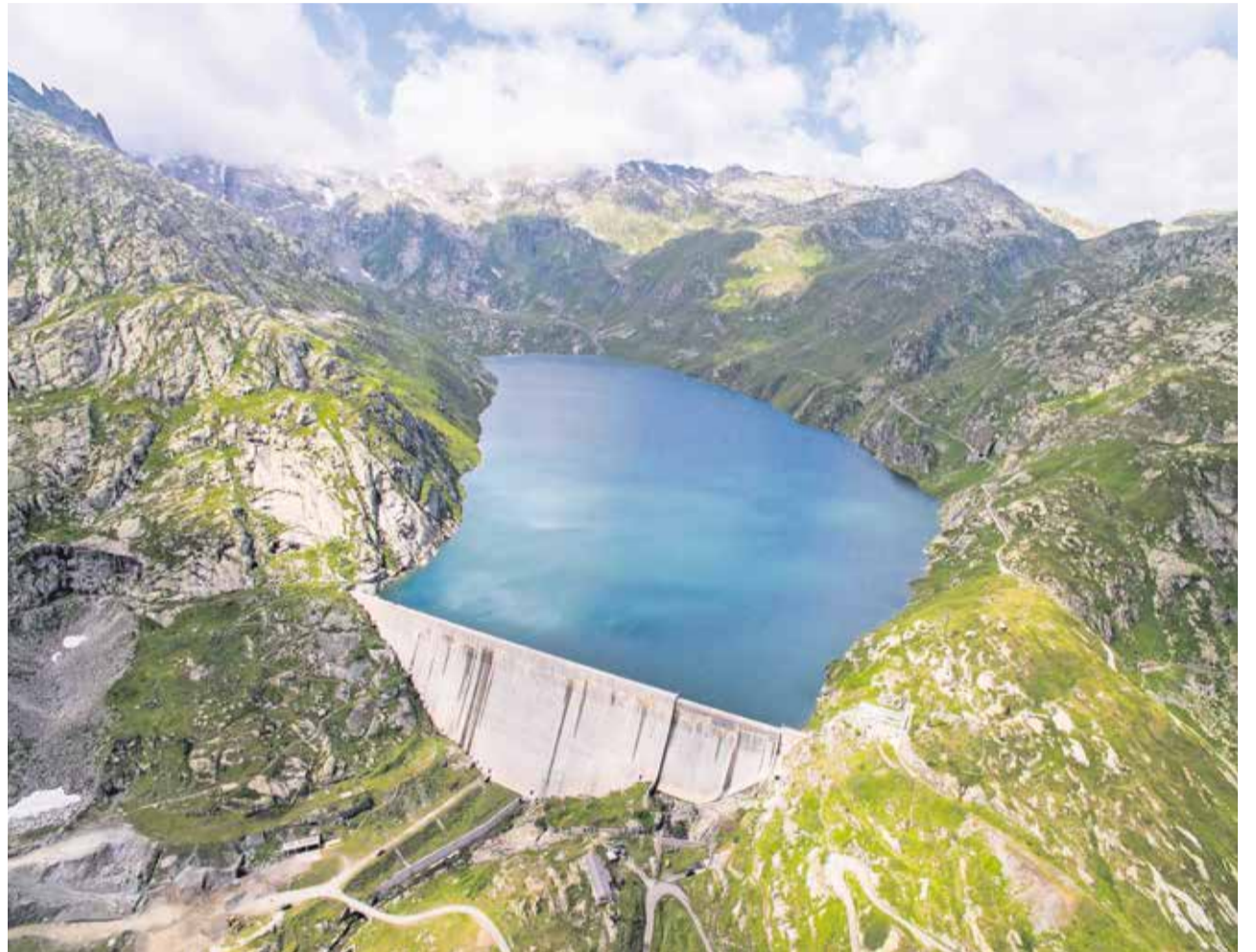
Das Kraftwerk Lucendro: Bei der Erneuerung der Konzession 2024 sollen die Anteile des Kantons Uri an das EWA übergehen und Uri im Gegenzug EWA-Aktien erhalten. FOTO: EWA ENERGIE URI
